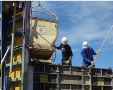
Remplissage des coffrages + vibrage
