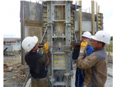
12 à 24h pour démouler, puis 60 jours pour la reprise de charge
